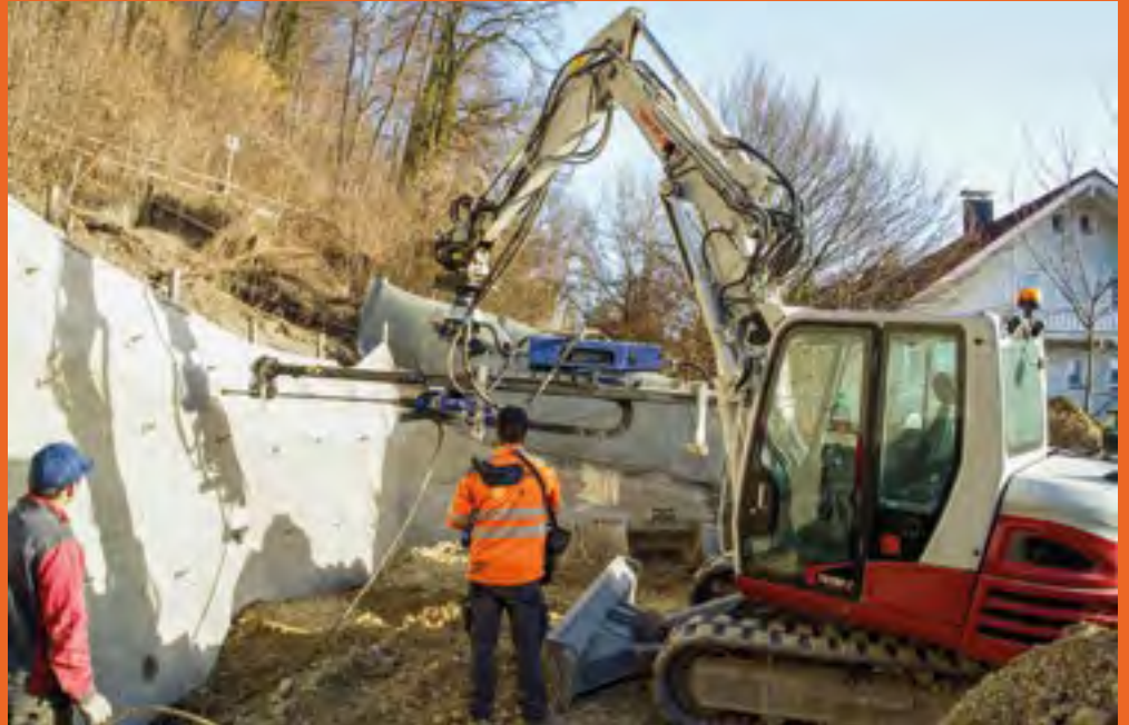
Sonderumbau: Kompaktbagger TB290 mit High-Flow-Hydraulik und Fernsteuerung
